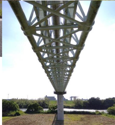
ガス導管は通常、地下に埋設されているが、川幅の広い河川を越えなくてはならない場合、地上に顔を出します。写真はガス導管専用の橋であるが、人や車両が通る橋の下に、ガス導管が敷設されることもある。
