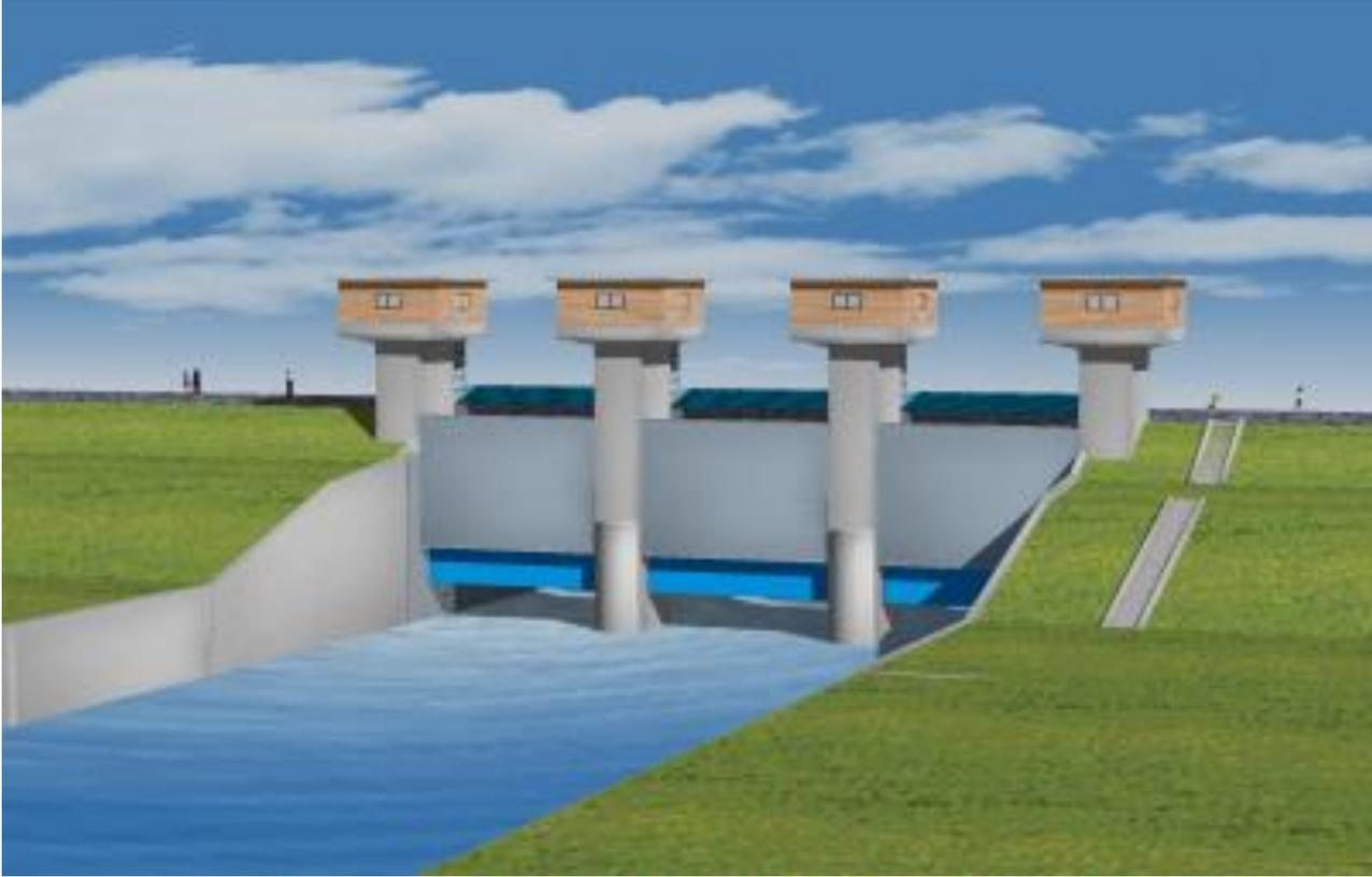
堤防を分断してゲートを設置する施設を水門と呼びます。
