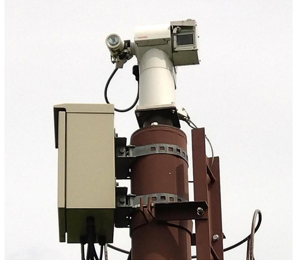
遠隔カメラで台風や豪雨時など河川の水位や降雨の情報など、水害に関する様々な情報をライブで収集できる。
