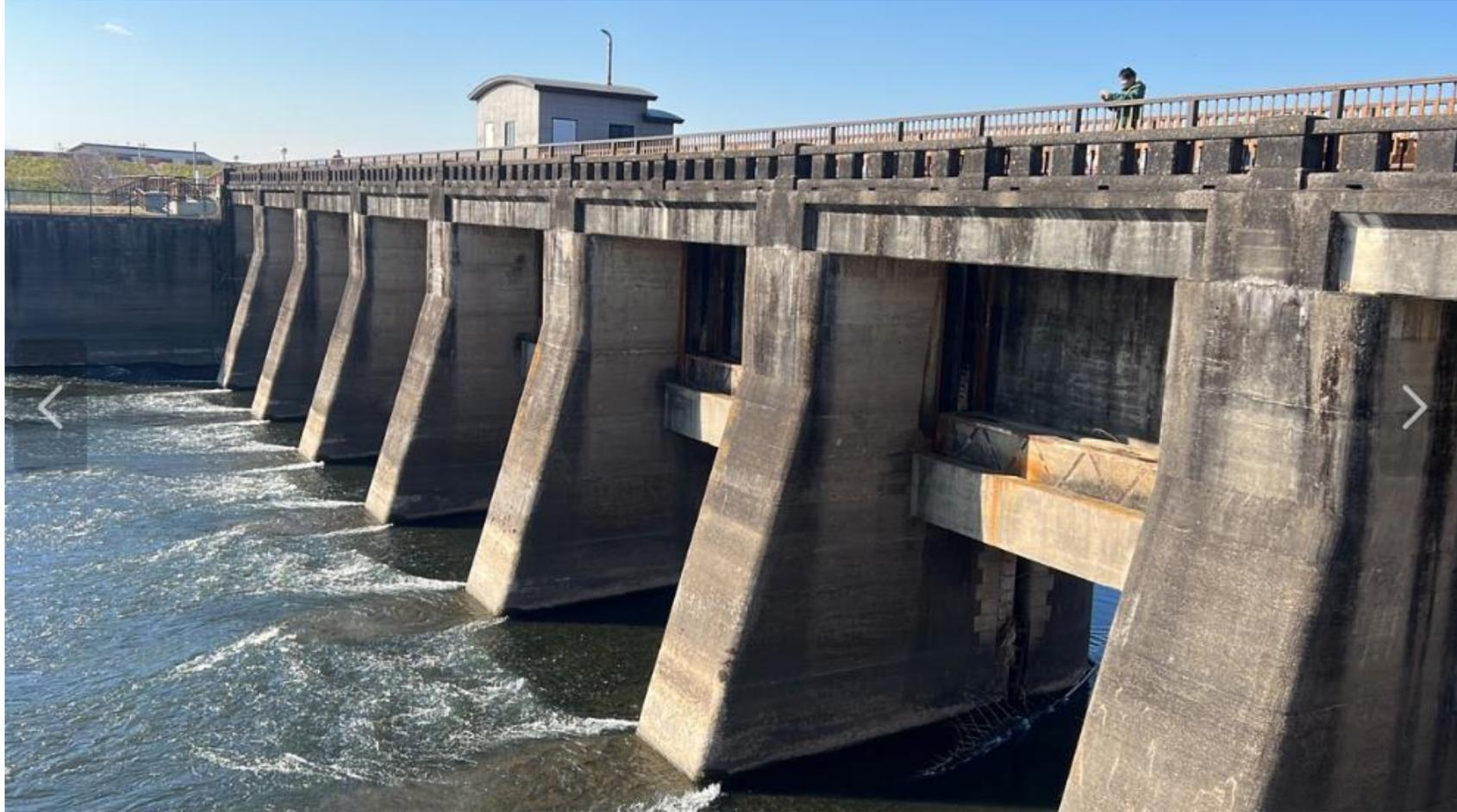
関宿水閘門は利根川から江戸川に入る水量と水位の調節を行うために設置された。昭和2年に完成。水閘門は流量調節を行う「水門」と船の航行のための「閘門」を併せ持つ施設である。水閘門が完成すると水量調節の役割を担ってきた「関宿棒出し」は昭和4年に撤去された。
