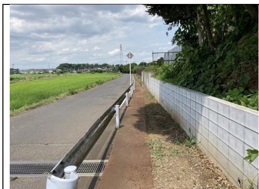
写真9. 場所②八幡神社下（鉄板のフタ）
