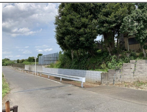
写真8. 「堀の痕跡」場所①（八幡神社の下）
