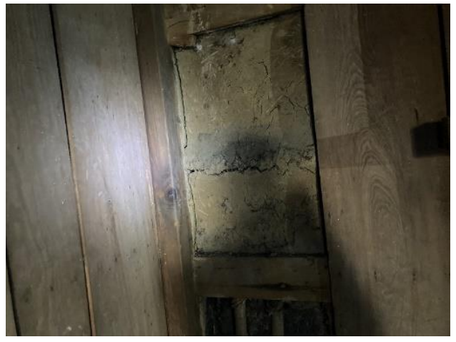
写真2：1階土壁部分
