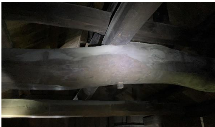
写真6：2階屋根部分の梁
