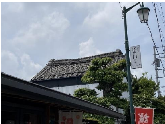
写真5：土蔵屋根外観
