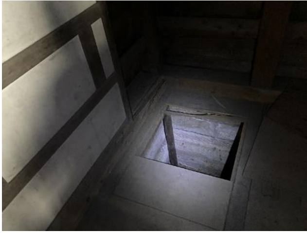
写真1：1階床下の大谷石部分
